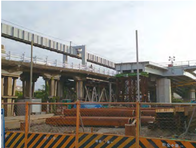
H25.5.27 小袋谷跨線橋の工事
