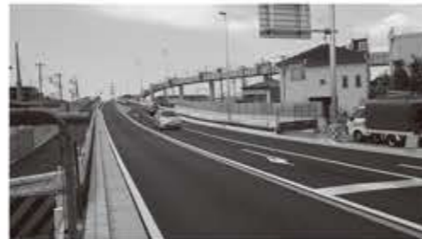
大船立体(小袋谷跨線橋)1期完成
